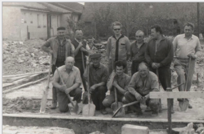
Stavění základů smíšeného obchodu Jednota Obora
